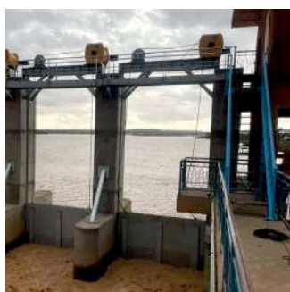
△ Industria 8 t an den Spülschützen einer Staustufe montiert.
