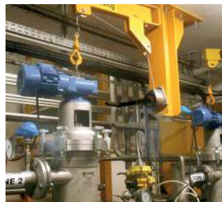
Elevación de una bomba.
