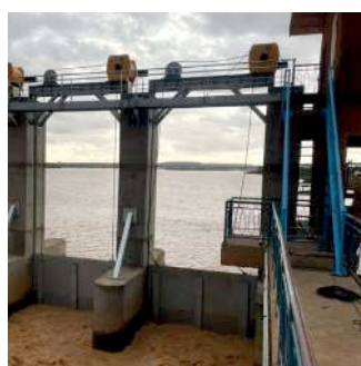
△ Industria 8 t instalados en las compuertas rasantes de una presa de retención de agua.
