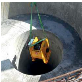
△ Elevación de grupos electrógenos in situ.
