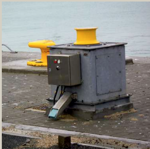
△ Cabestrante con control mediante pedal. Capacidad: 1,5 t. Velocidad: 25 m/min.
